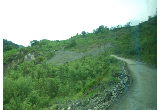
그림 3. 안데스 산사면의 주요 도로, 비포장, 1차선 출처 : 2017년 4월 저자 촬영.
